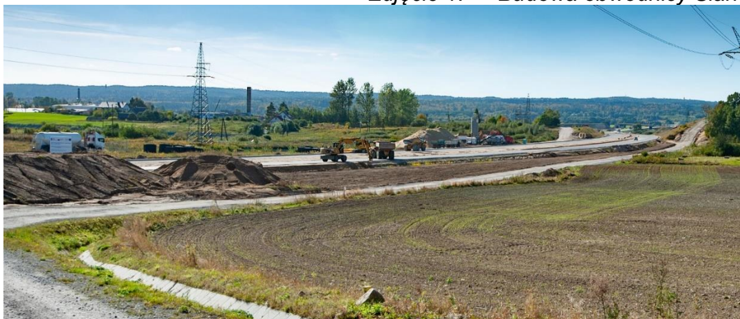
Zdjęcie 1. Budowa obwodnicy Sianowa
