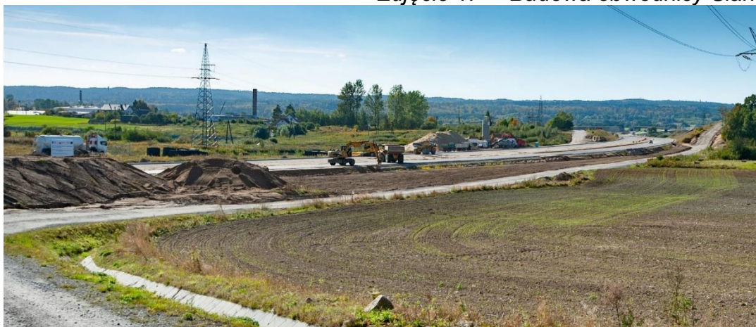
Zdjęcie 1. Budowa obwodnicy Sianowa
